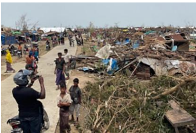
サイクロンによる被害の様子
